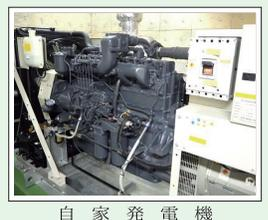
それから医療用酸素の管理も大事な仕事です。酸素ボンベ数も毎日の使用量を目安に管理します。自動の警報盤も作動しますが、残量はいつも頭の隅に置いてありますね。停電時の自家発電機（ディーゼルエンジン）とポータブル発電機も定期的に運転しメンテナンスしています。
